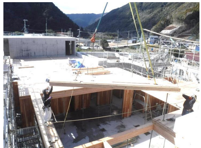
丁度クレーンで CLT を設置しているところ
