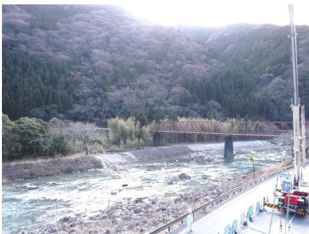
完成すれば窓からは北川村の美しい景色が見える
