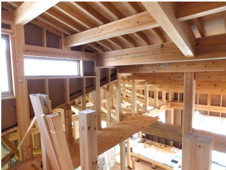
写真は神戸市で建築中の土佐材住宅構造見学会(29/2)
