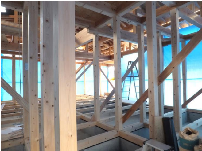
写真は兵庫県加古川市で建築中の土佐材を使用した住宅(28/12)
