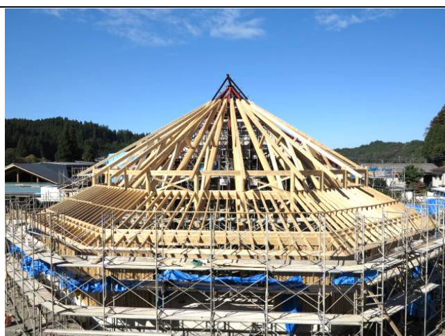
南小国町議場棟建築中
