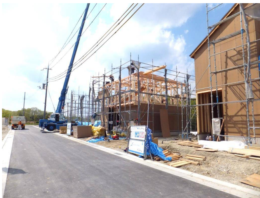
写真は神戸市北区の建築現場 4/19
