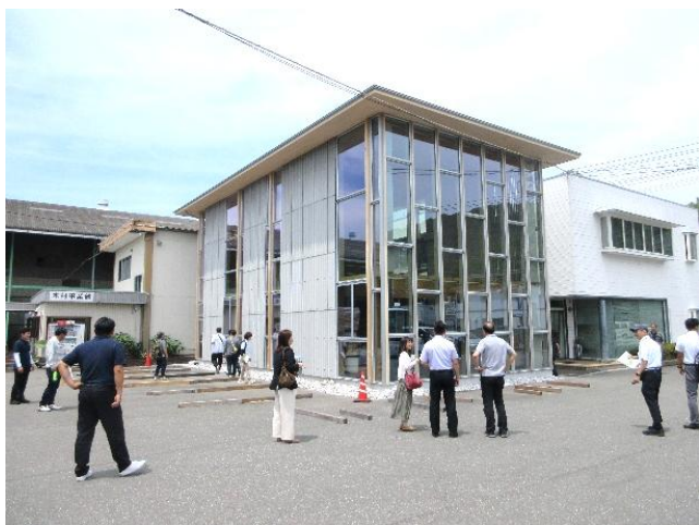
ウッドテクノス(株)本社ビル
