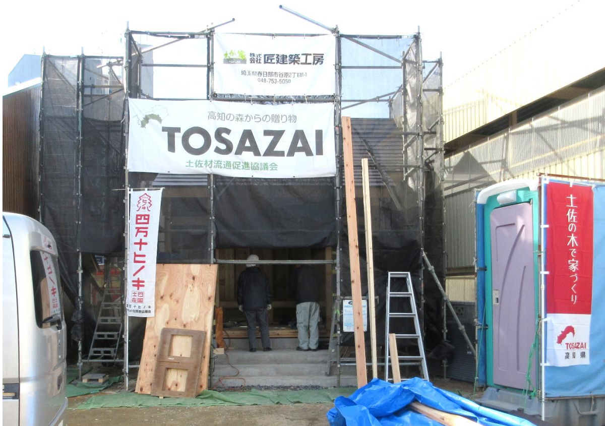
土佐材 PR 中の建築現場
