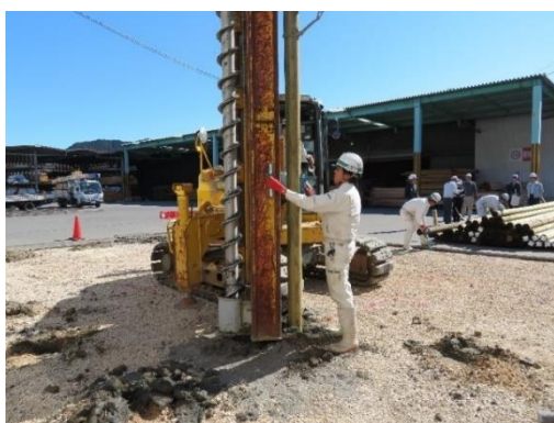
作業中の様子
