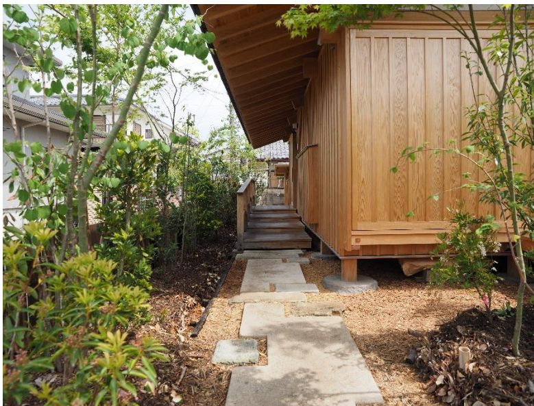
石場建ての柱脚廻り
