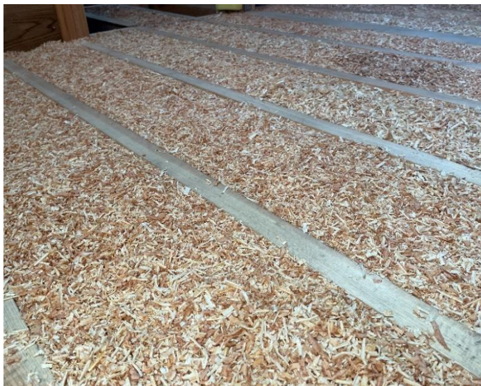
断熱材に再利用される木の皮や削り屑
