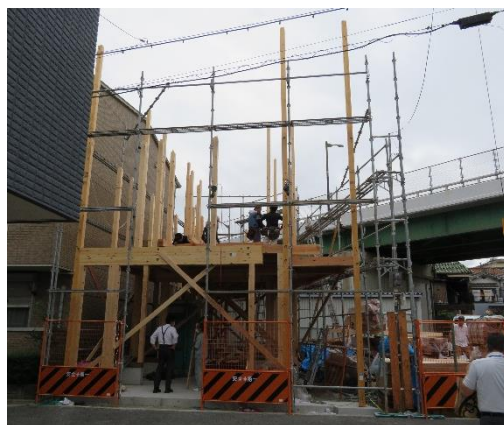
建築中の土佐材住宅（大阪府寝屋川市）
