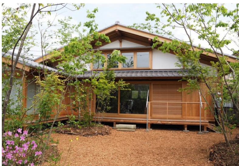
施工事例 ～雑木の庭に建つ石場建ての家～ 埼玉県川越市
